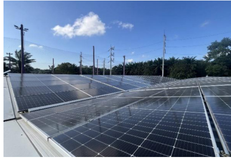
การติดตั้งโซลาร์เซลล์บนพื้นที่ โรงงานสาขาตราด
