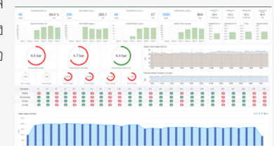
โครงการ Smart Energy System
