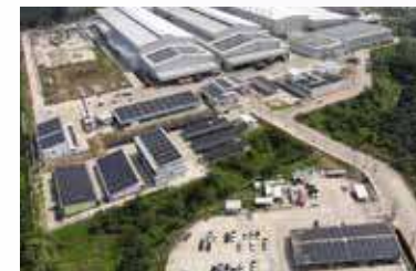
การติดตั้งโซลาร์เซลล์บนพื้นที่โรงงานสาขาชุมพร
