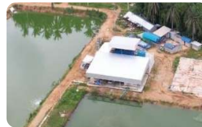
1. ตำแหน่งติดตั้ง Reclaim Water System
