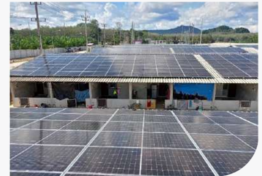
การติดตั้งโซลาร์เซลล์บนพื้นที่หลังคาบ้านพัก พนักงานรายวันที่โรงงานสาขา ชุมพร
