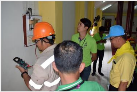
โครงการจิตอาสาพิทักษ์ศาสนสถาน ตรวจสอบและปรับปรุงระบบไฟฟ้า
